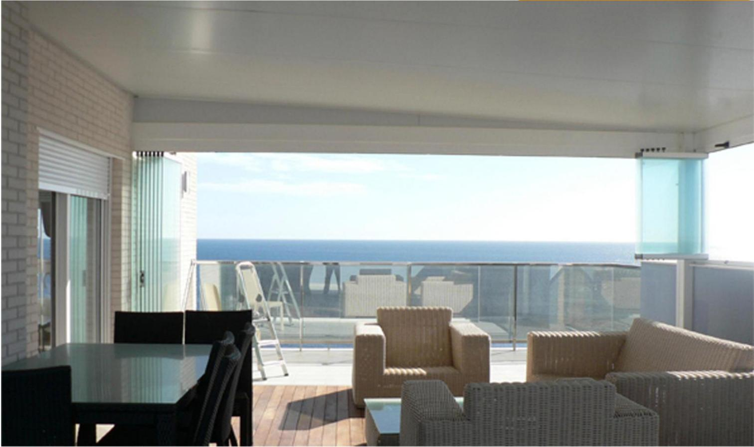
CUBIERTA FIJA PANEL SANDWICH ALUMINIO
